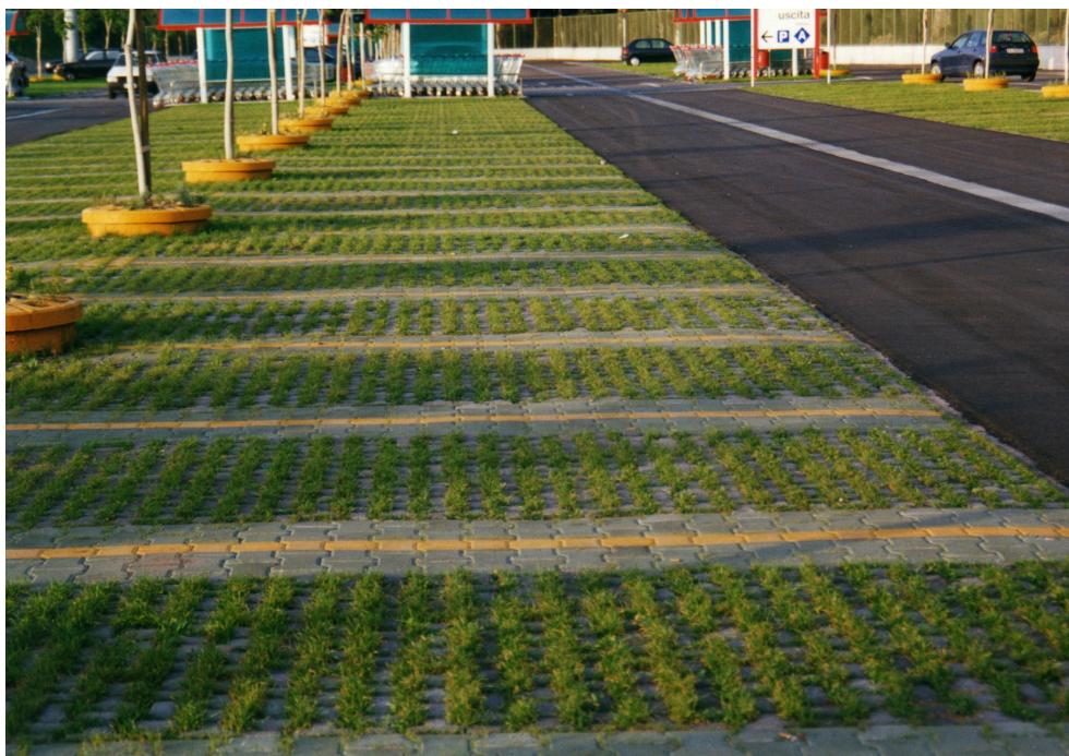
Figura: Posa di pavimentazione drenante con massello filtrante in cls
